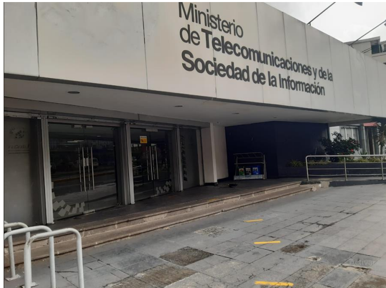
Figura 8. Salida de Emergencia del centro de trabajo MINTEL
